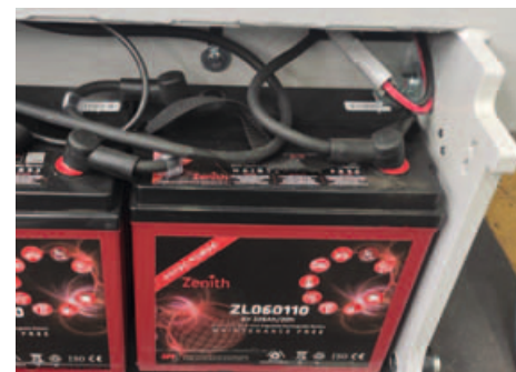
Compartiment pentru bateriile AGM
